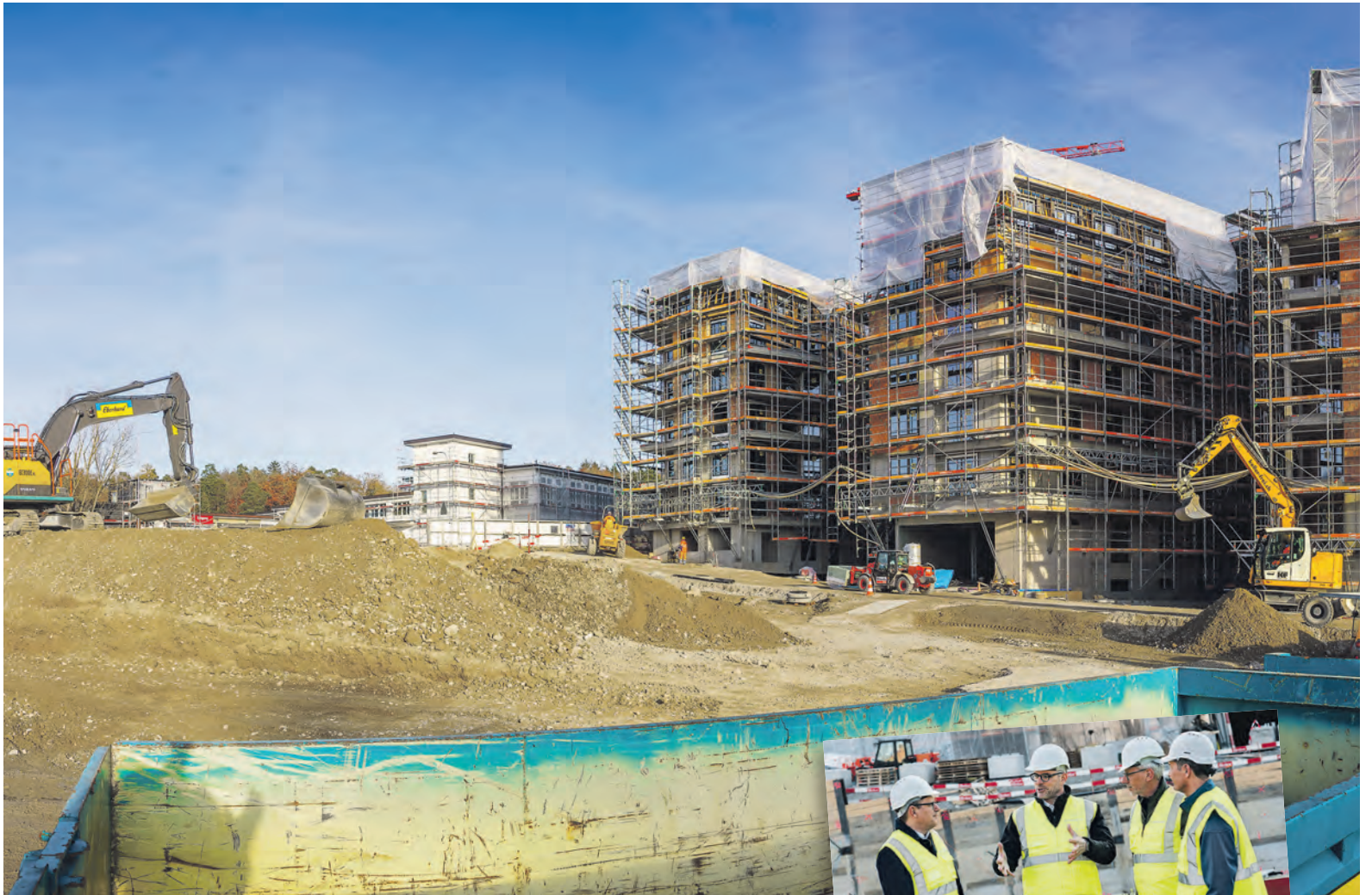
Othmar Ulrich, Geschäftsleitungsmitglied Steiner AG, Martin Bieber und Mark A. Wisskirchen, Geschäftsleiter und Stiftungsratspräsident der Stiftung Wisli sowie Beat Schmid, Gesamtprojektleiter Ausführung Steiner AG, vor der Baustelle von Haus A.
