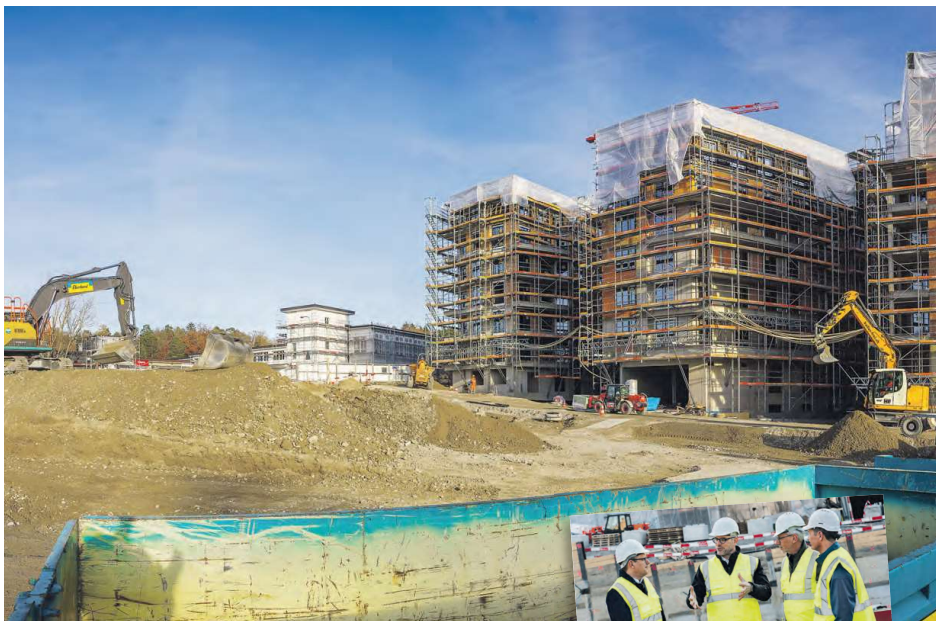
Othmar Ulrich, Geschäftsleitungsmitglied Steiner AG, Martin Bieber und Mark A. Wisskirchen, Geschäftsleiter und Stiftungsratspräsident der Stiftung Wisli sowie Beat Schmid, Gesamtprojektleiter Ausführung Steiner AG, vor der Baustelle von Haus A.
