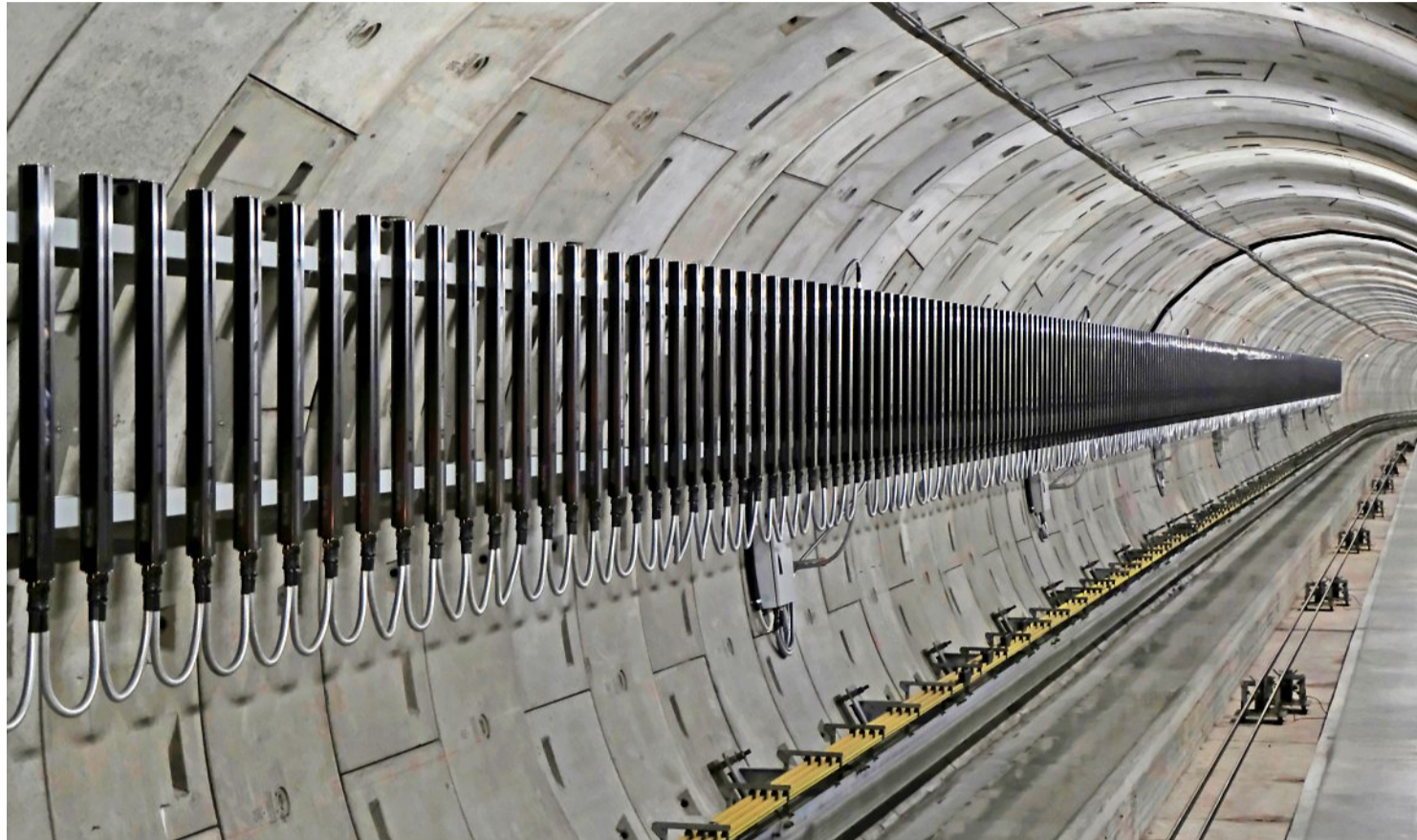
Wenn die Skymetro an den 432 LED-Sticks vorbeifährt, können die Passagiere fließende Bilder sehen. Foto: Heinz Diener
