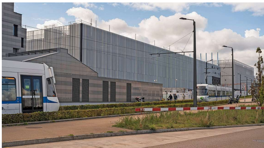
Dank der Rechenzentren in Opfikon können ab 2025 die Gebäude südlich des Flughafens geheizt werden. Archivfoto: Urs Jaudas
