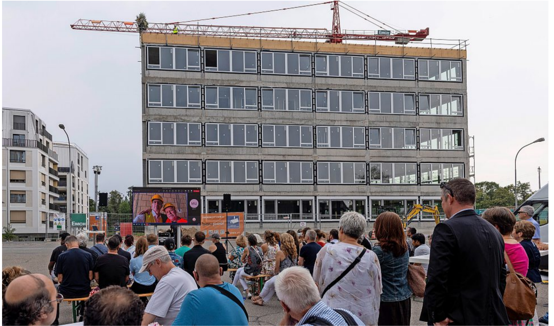
Das Gebäude steht, nun erfolgt der Innenausbau. Hier kommt der Campus der Stiftung Wisli hin. Foto: Patrick Gutenberg
